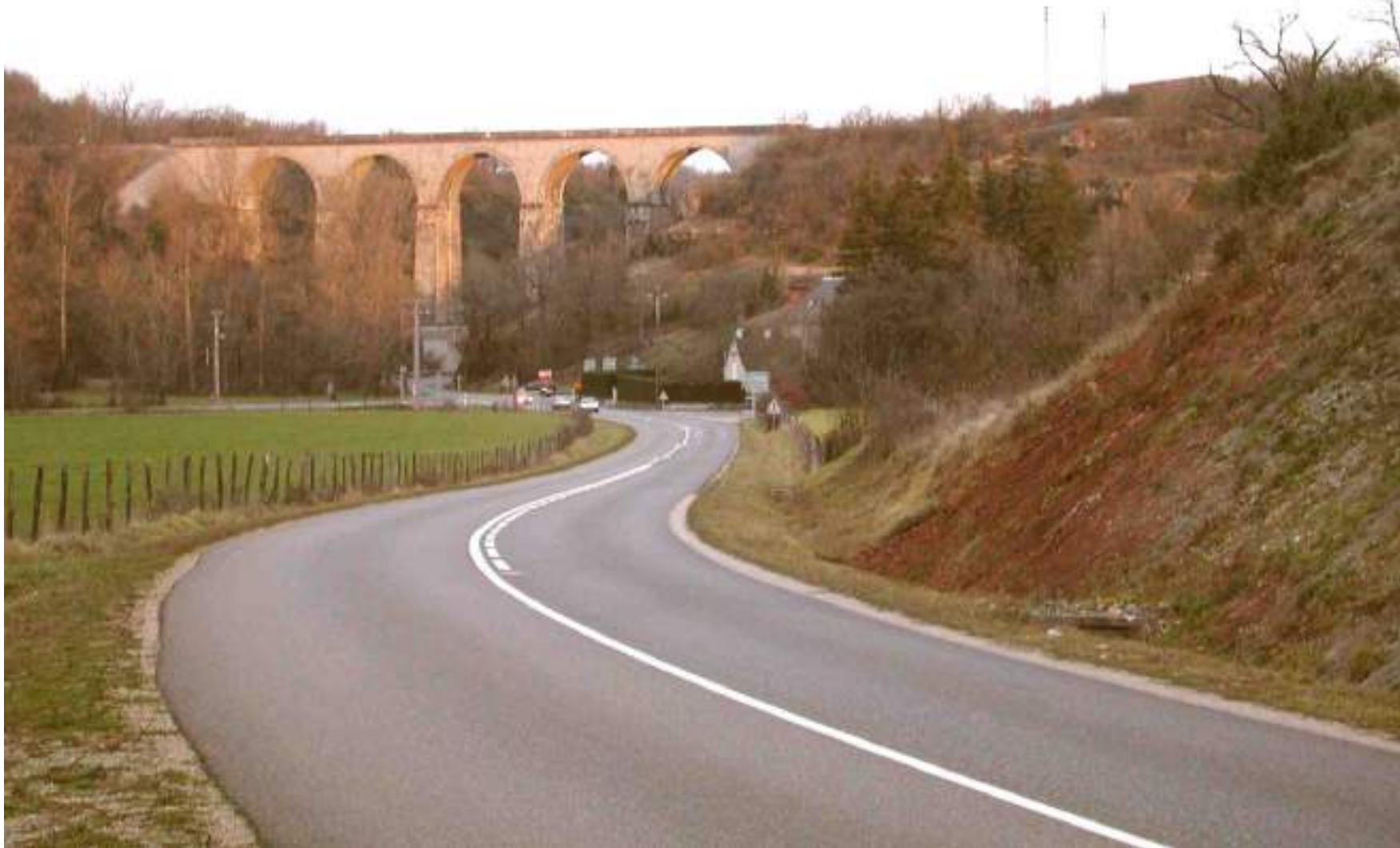
Le viaduc de Cadoul, sur la faille entre grès permien et calcaires du jurassique
